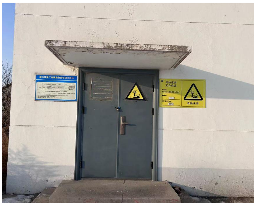
图7-1 危废暂存间外部照片
